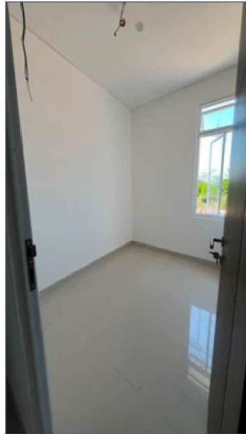
Pekerjaan cat/ keramik
