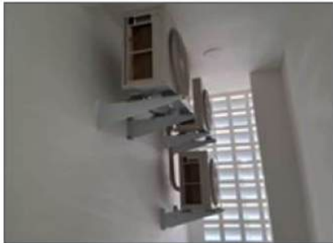
Pekerjaan out door AC
