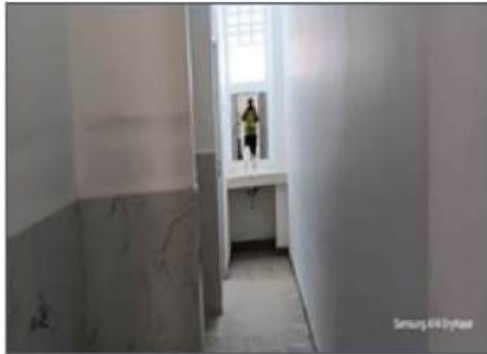
Pekerjaan tempat wudhu
