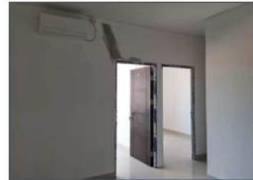
Pekerjaan indoor AC
