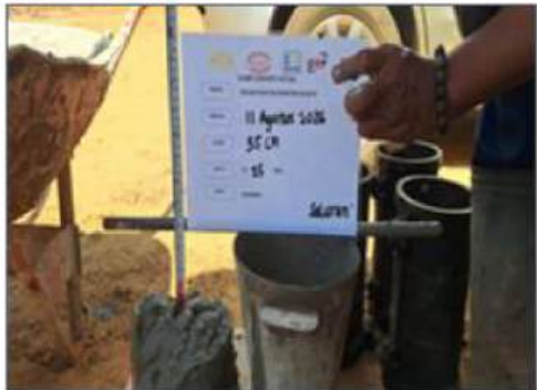
Slump test beton saluran
