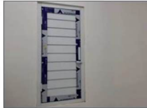
Pekerjaan indoor AC
