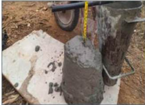
Slump test beton saluran
