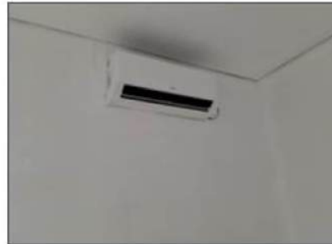
Pekerjaan indoor AC
