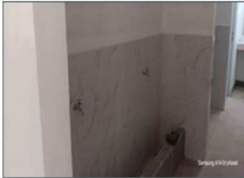
Pekerjaan tempat wudhu
