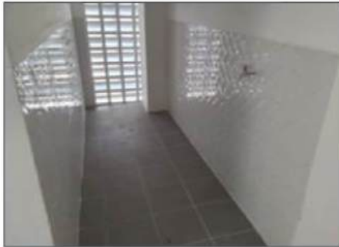
Pekerjaan out door AC
