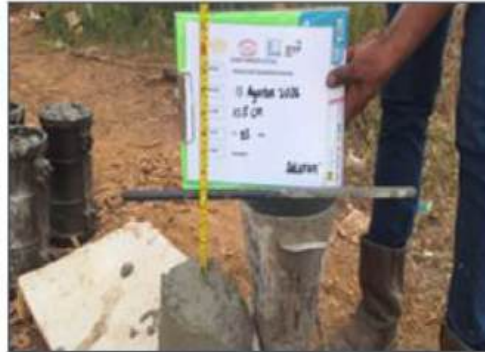
Slump test beton saluran
