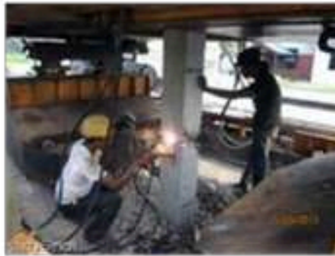
Gambar 12 Proses pengelasan sambungan tiang pancang
