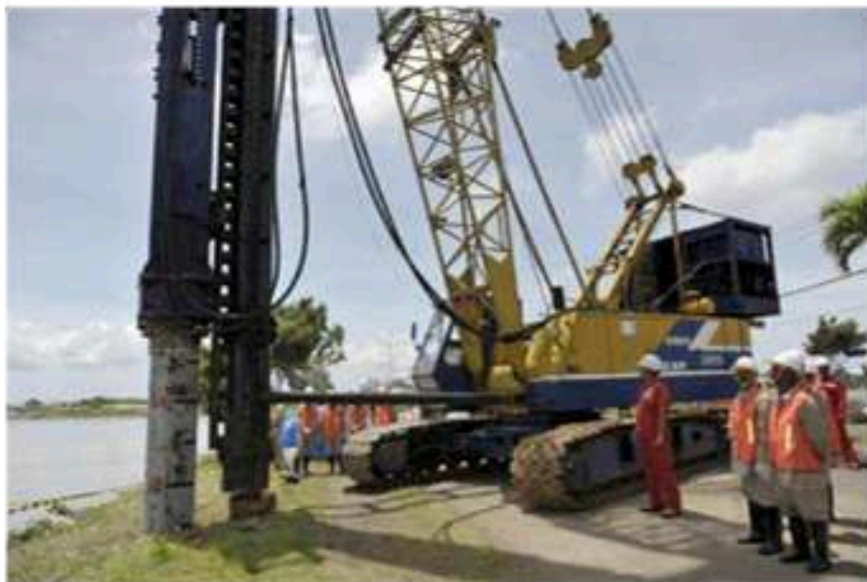
Gambar 3 Alat pancang di lokasi proyek
