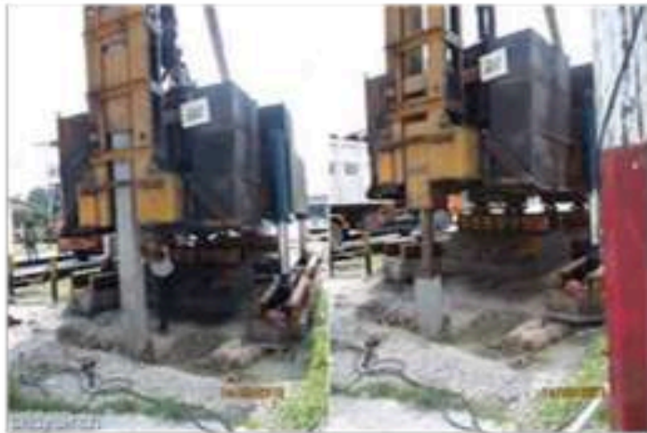
Gambar 7 Penetrasi tiang pancang
