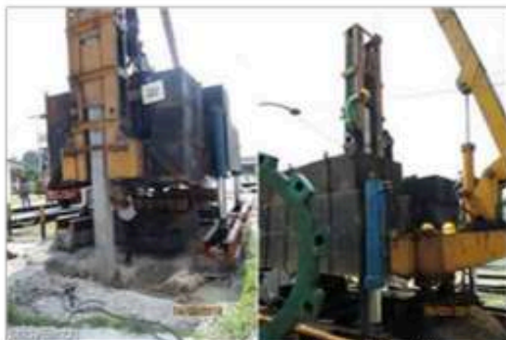
Gambar 8 Posisi grip jack-in pile (kanan-kiri: grip ujung dan tengah)
