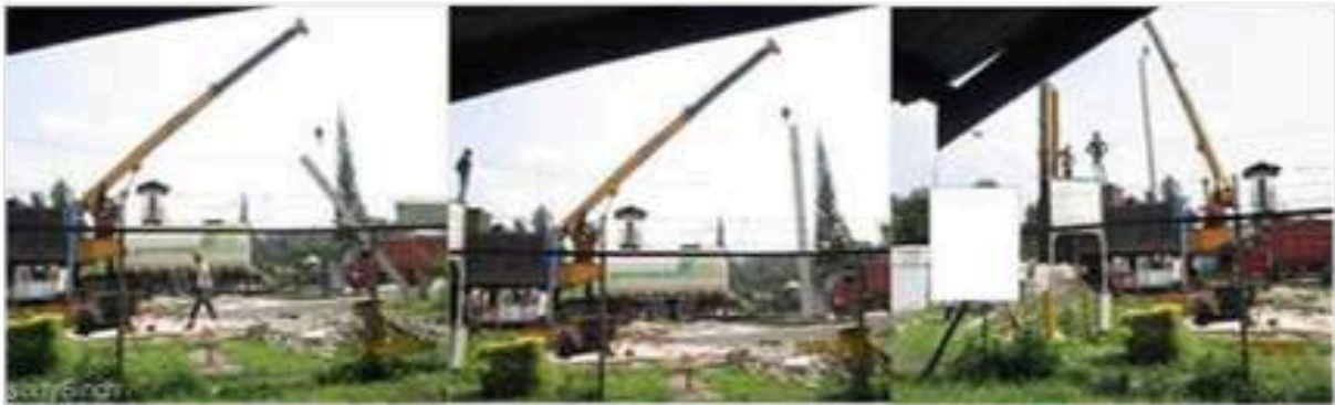
Gambar 6 Proses pengangkatan tiang pancang
