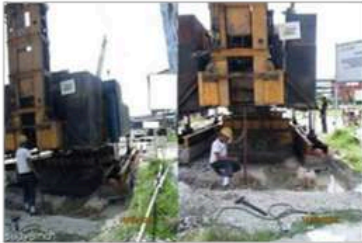
Gambar 5 Setting titik pancang
