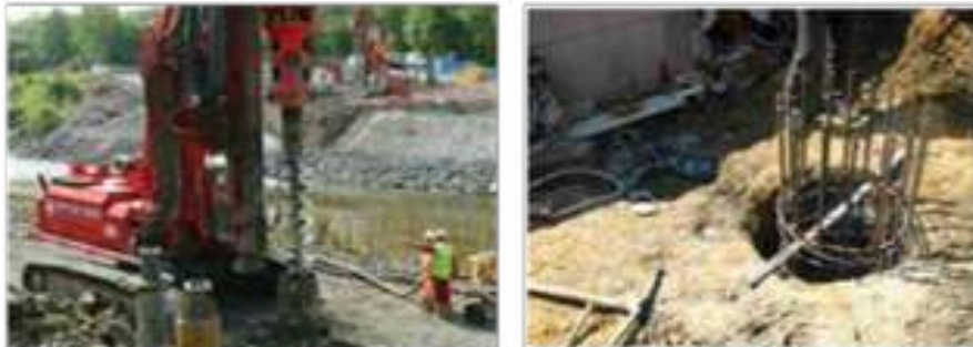
Gambar 15 Penyiapan Bore Pile
