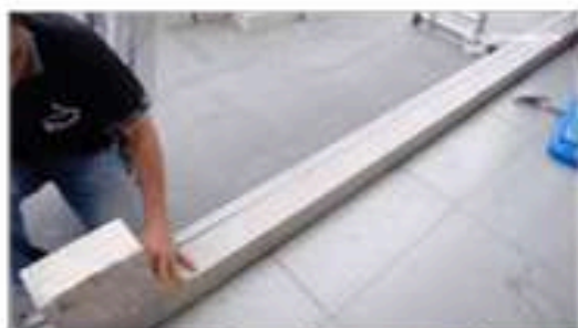
Ukur bagian dinding yang akan dipasang glassblock dengan akurat
