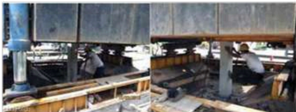
Gambar 9 Posisi operator pancang selama proses pemancangan
