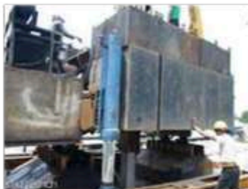
Gambar 14 Penggunaan dolly untuk membantu memancang
